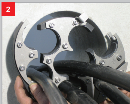
2 先将洋葱圈式嵌件从GPD系统中取出， 将系统打开，依次将电缆放入相应的穿 越孔中
