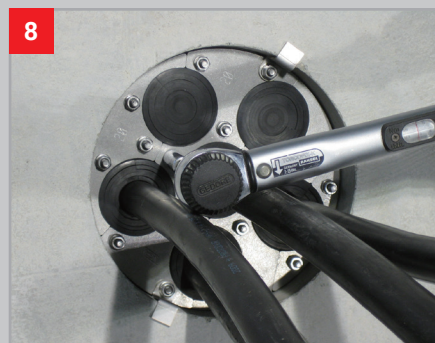
8 按规定的力矩拧紧螺母。 即可实现高达 2.5 bar 的气密水密防护!
